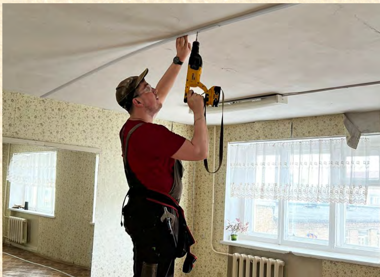
На фото: Проведение специалистами отделения работ по проверке огнетушителей, монтаж систем автономной пожарной сигнализации в одной из организаций города Воркуты.
